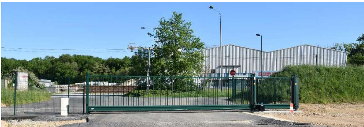
Figure 7 : Vue depuis l'intérieur du site sur le portail et la zone de stationnement temporaire externe (ENCEM, mai 2023)
