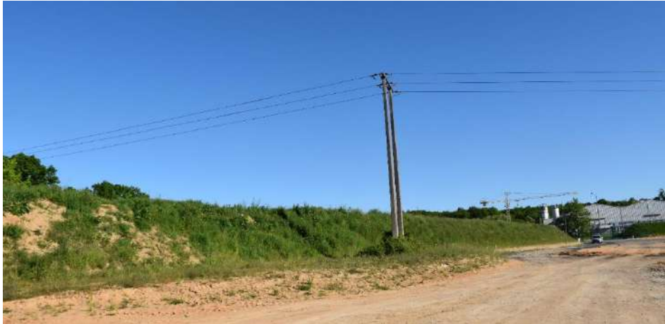
Figure 37 : Ligne haute tension aérienne traversant le site du projet (ENCEM, mai 2023)
