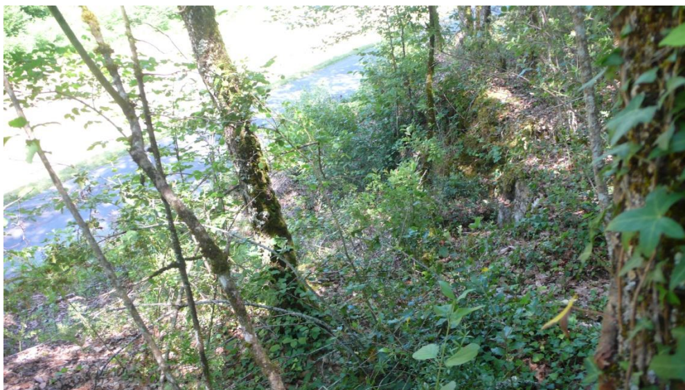
Figure 44 : Fracture (vue en direction de la route)
