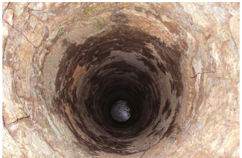
Figure 43 : Vue intérieure du puits
