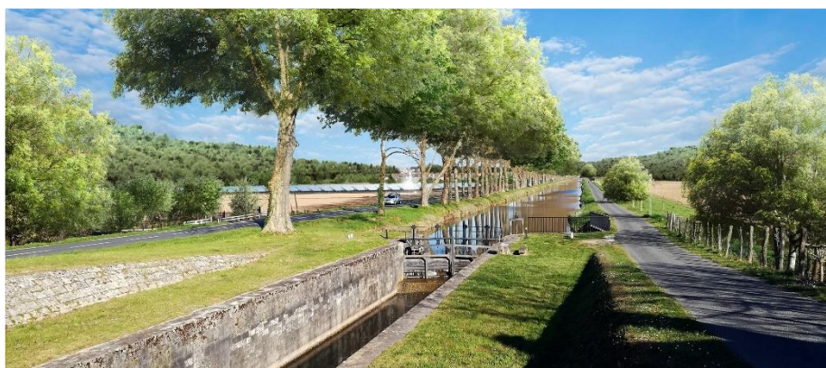
Vue 2 – Après aménagement paysager à l'est le long de l'usine POLYREY
