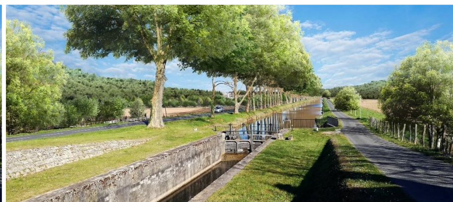
Vue 2 – Après aménagement paysager complet (vue façade sud et ouest)
