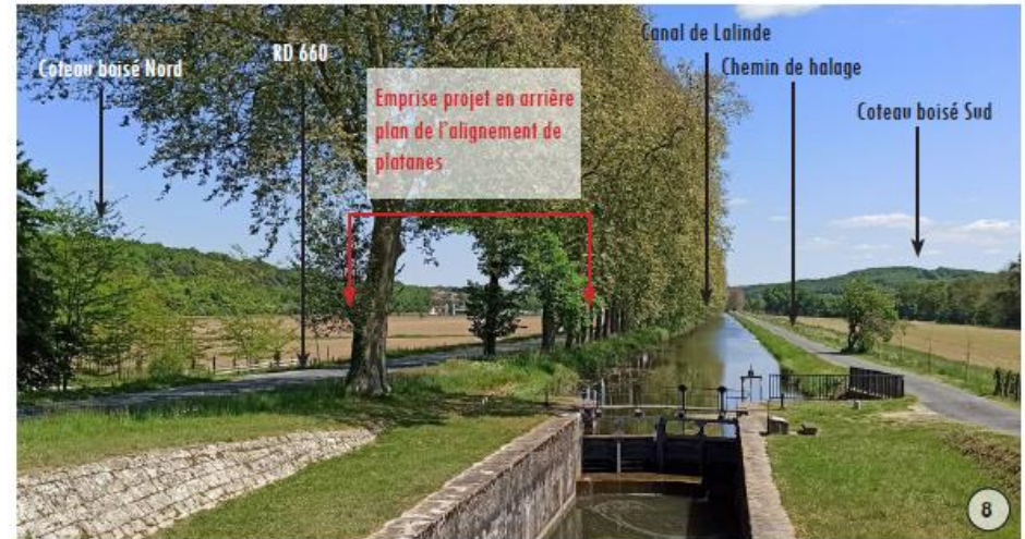
Vue depuis l'écluse de la Borie-Basse (classée Monument Historique) : l'emprise de projet est visible, malgré le filtre des platanes d'alignement de la RD660
