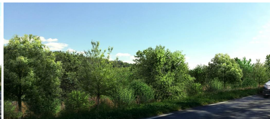
Vue 1 – Après aménagement paysager complet du site (vue façade sud)
