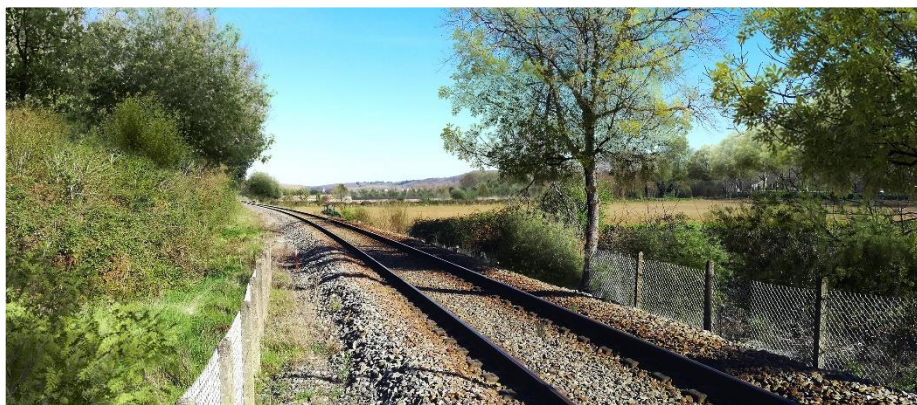
Vue 4 – Après aménagement paysager depuis la voie ferrée
