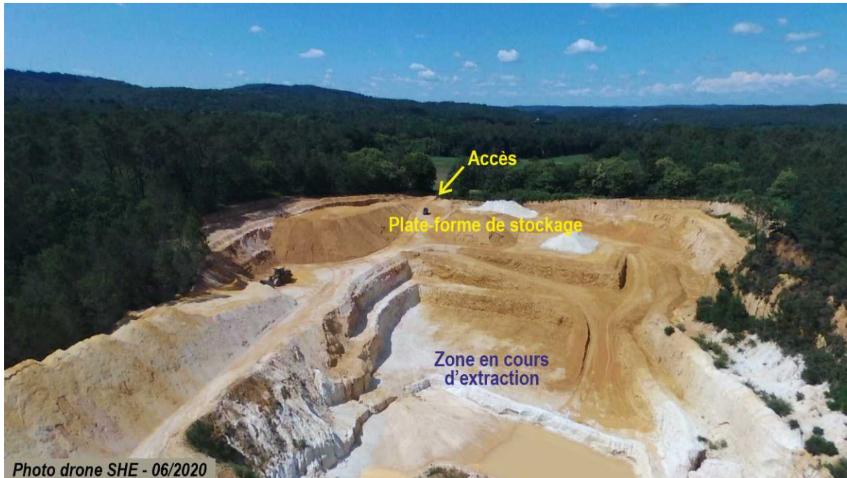
Illustration 2 : Vue depuis la partie Sud du site
