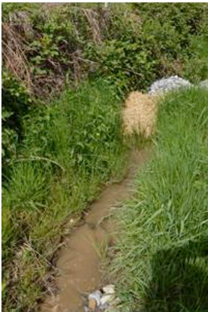
Exemple d'intervention avec installation d'un filtre à paille
