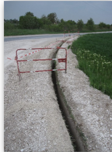
Exemple de tranchée réalisée
