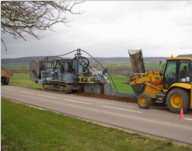
Pose du câble de raccordement
