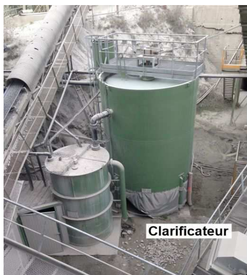
Illustration 2 : Clarificateur et flocculateur (circuit des eaux de l'installation)
