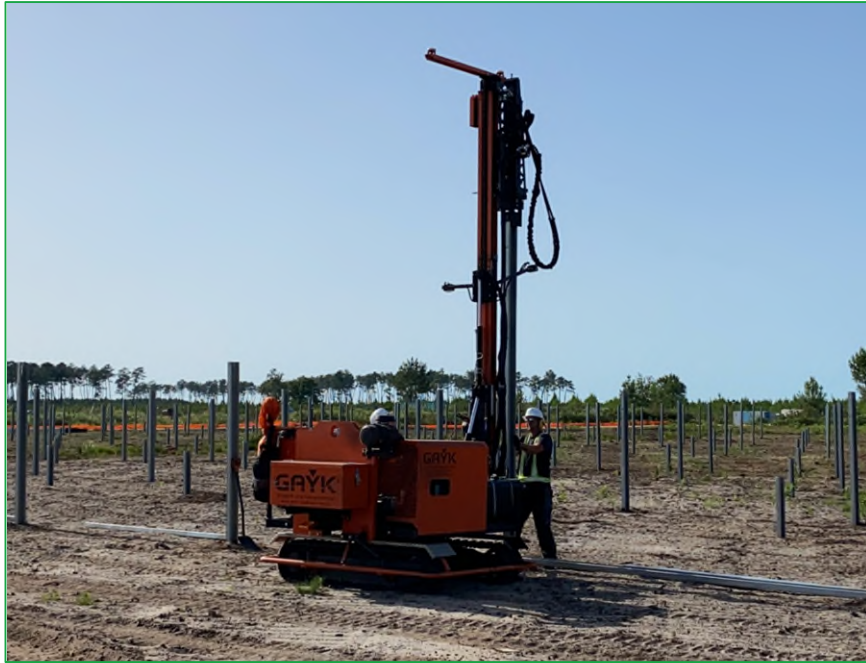
Figure 11 : Exemple de pieux vibrofoncés
