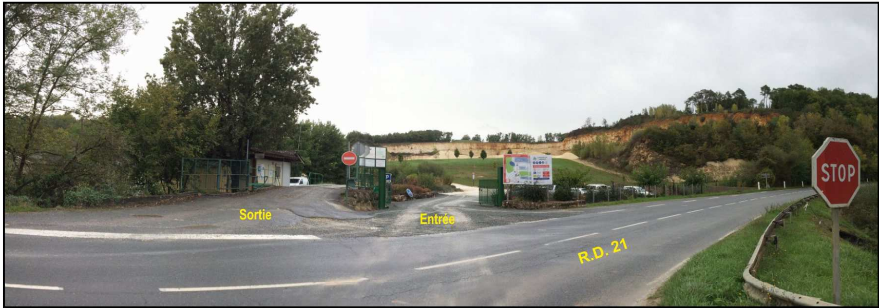
▲ PHOTO A: Vue d'ensemble de l'accès
