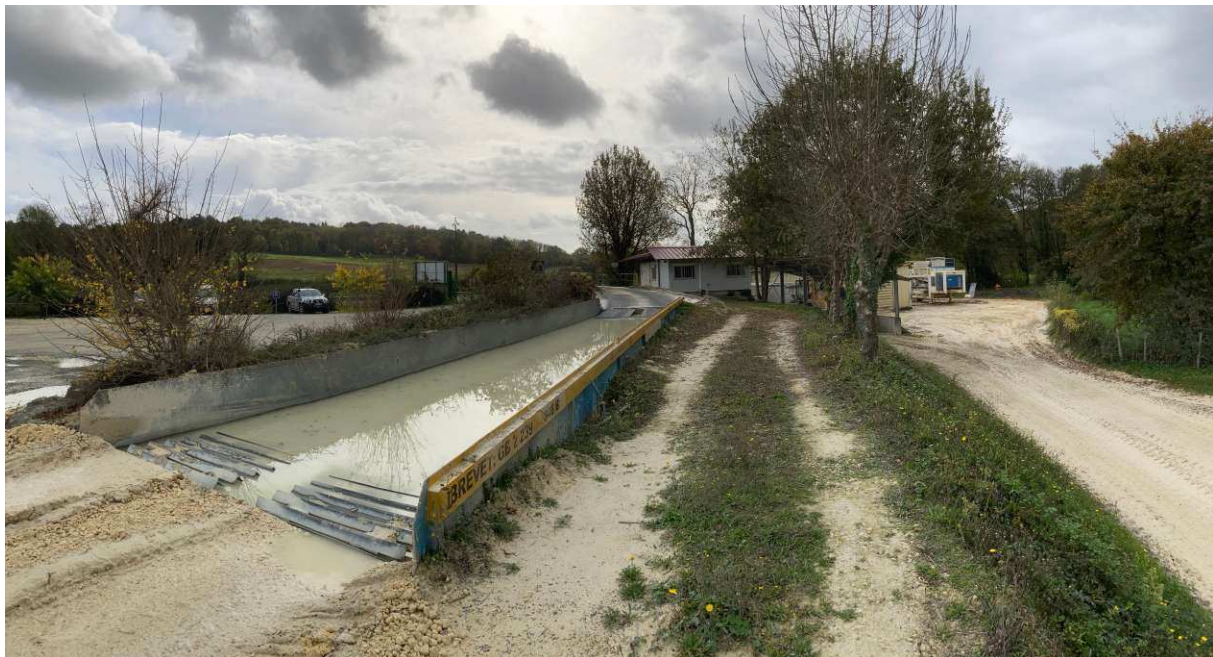
Illustration 13 : Dispositif de nettoyage des roues en sortie de site
