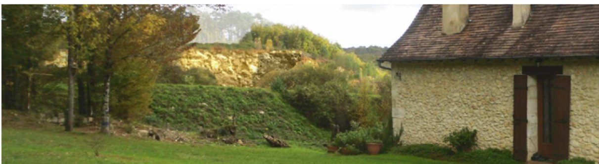
Vue 13 - Maison adjacente : effet d'entame et augmentation du réfléchissement lumineux en fin de journée
