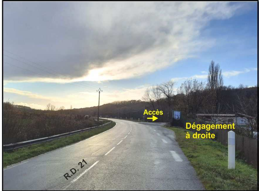
▲ PHOTO B: Vue sur l'accès depuis la RD 21, sens Périgueux - Bergerac
