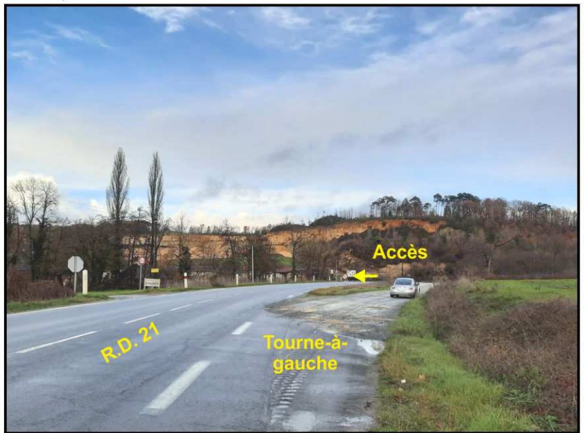
↓ PHOTO C: Vue sur l'accès depuis la RD 21, sens Bergerac - Périgueux
