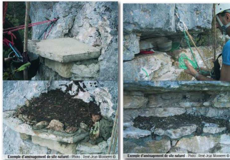
Figure 5. Exemples de deux aménagements effectués en carrières pour le Faucon pèlerin (à gauche une plateforme, à droite une cavité).
