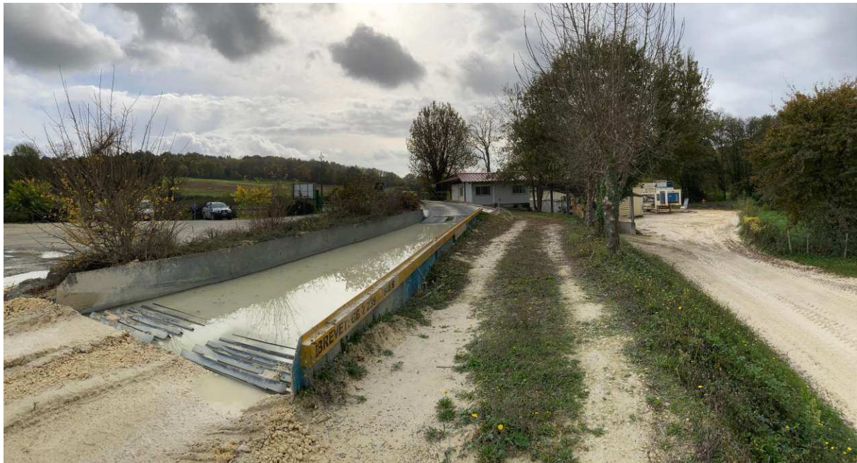
Illustration 8 : Dispositif de nettoyage des roues en sortie de site
