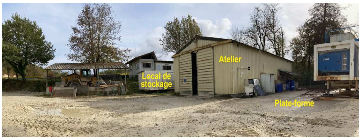
Illustration 7 : Photos des infrastructures
