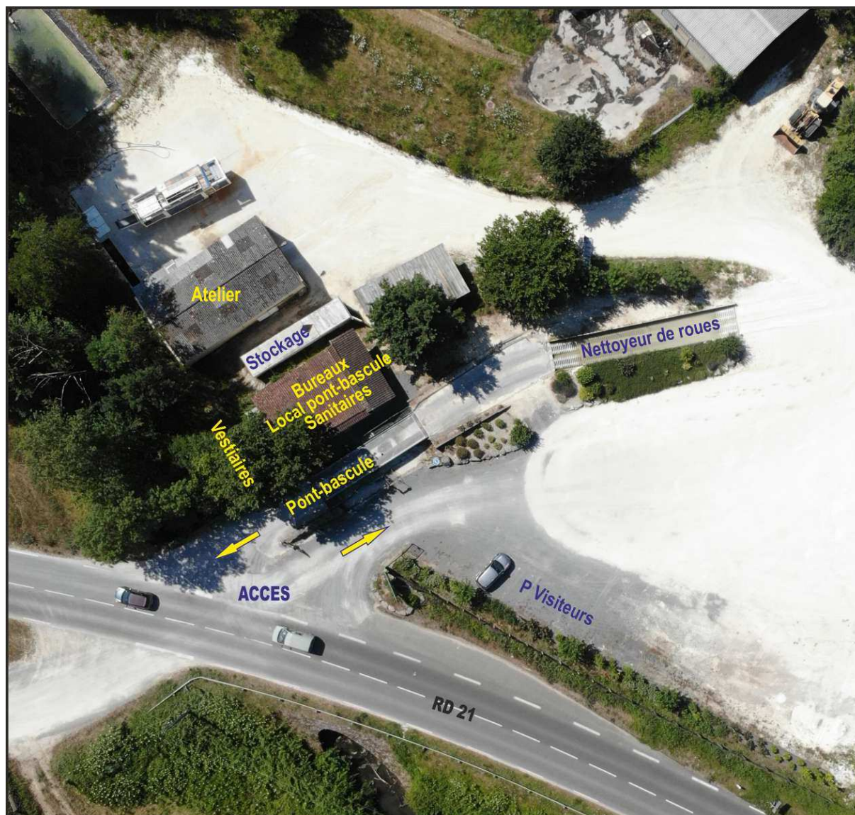
Illustration 6 : Vue aérienne du secteur des infrastructures
