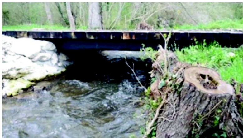
Exemple de traversée du ruisseau qui sera aménagée sous forme de tablier posé de berge à berge ( photo de principe hors site )
