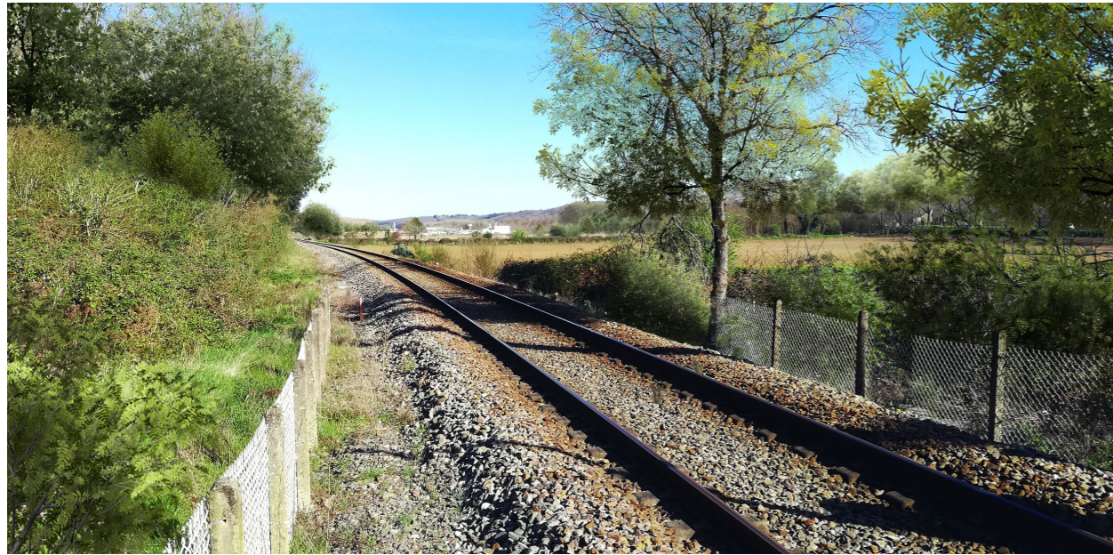
Photographie de l'état existant ( Mai 2021)
