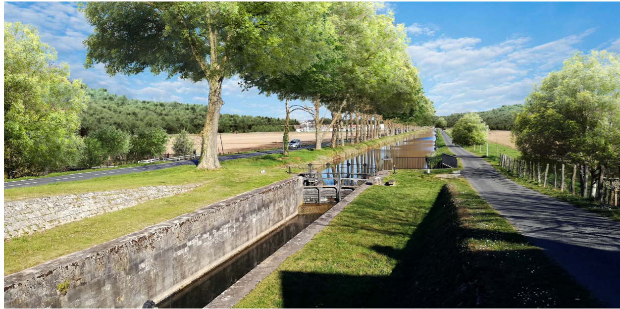
Photographie de l'état existant ( Mai 2021)
