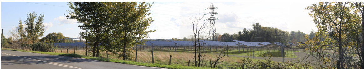
PM3 - Vue depuis la RD 6089 en direction de Montpon-Ménéstérol
