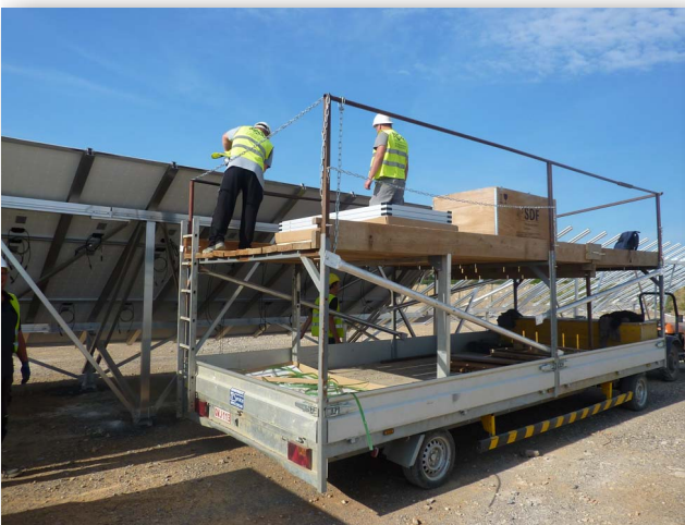
Pose des panneaux photovoltaïques
