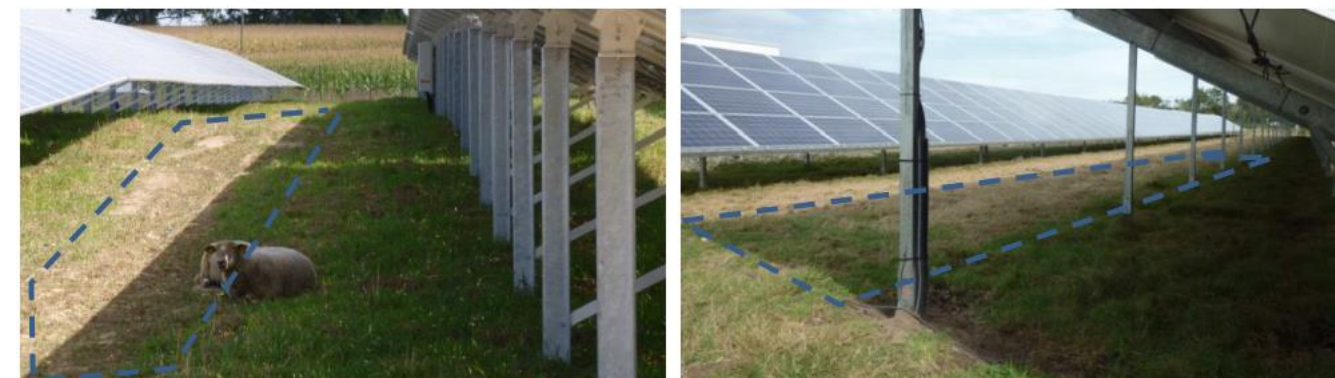
Protection des modules contre le dessèchement de la végétation en fin d'été à gauche parc de Philondenx en septembre 2012, à droite parc de Saint-Aubin-de-Blaye en septembre 2014 (en bleu : zone plus sèche)
