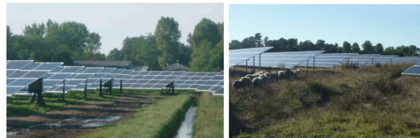
Reprise de la végétation sur les zones où la végétation a été dégradée lors du chantier Parc solaire de Saint-Aubin-de-Blaye (Gironde) : en novembre 2013 (fin des travaux), et en juin 2014
