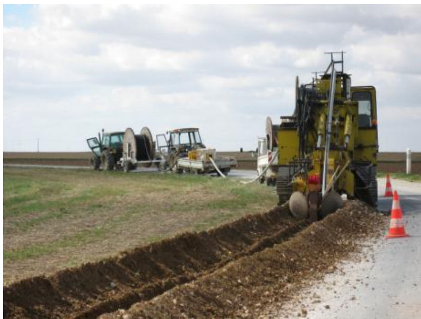
Illustration des travaux de raccordement réalisés par ENEDIS (source : EDF Renouvelables)
