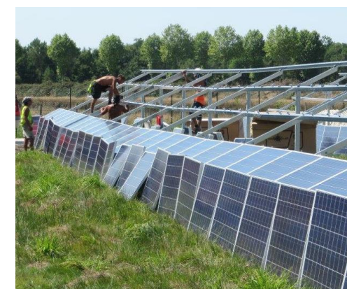
Pose manuelle des modules - Source : Luxel
