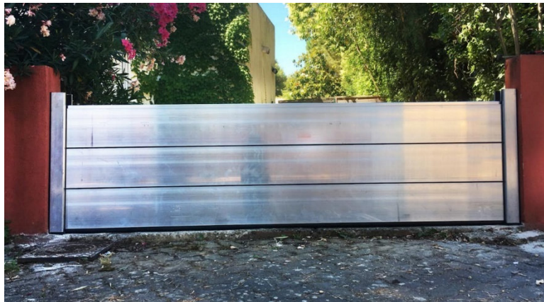
Figure 28 : exemple de batardeaux métalliques
