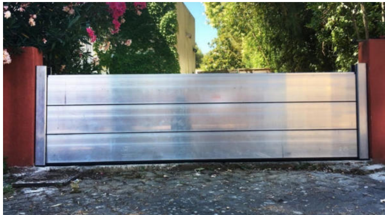
Figure 28 : exemple de batardeaux métalliques
