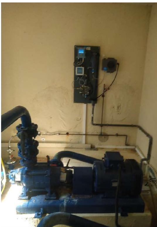
**Photographie 4 : Dispositif de pompage et appareil de mesure en continu (le 16/05/22).**
