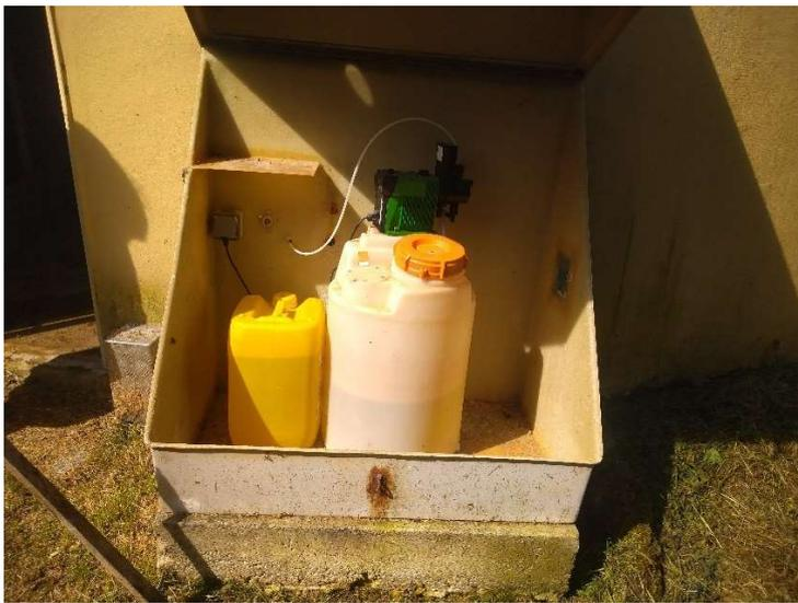
**Photographie 3 : Dispositif de Chloration (le 16/05/22).**
