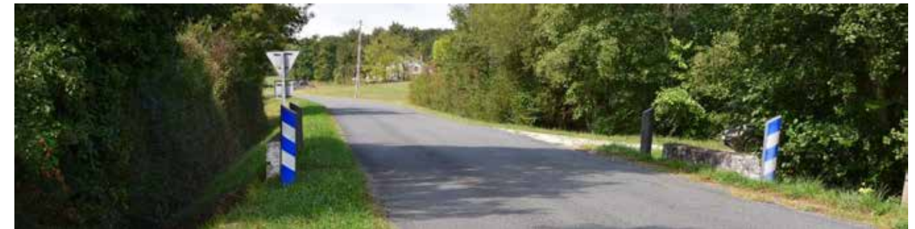
Figure 5 : La Beauronne au niveau de la commune de Les Lèches (source : ATER Environnement, 2020)
