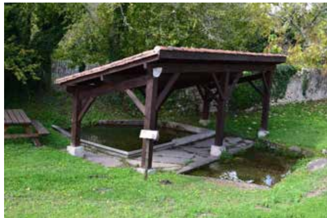
Figure 18 : Lavoir de Les Lèches
