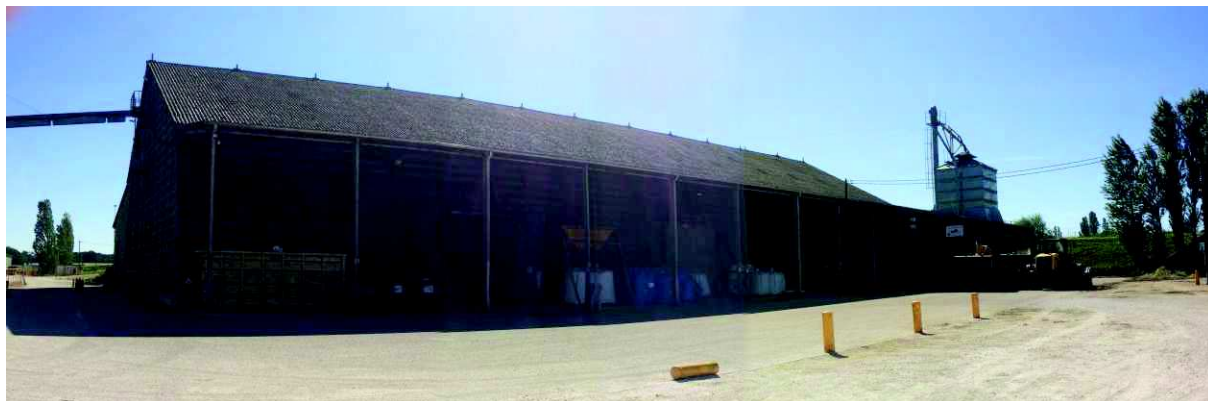
Illustration 6 : Bâtiment de stockage vrac et sacs
