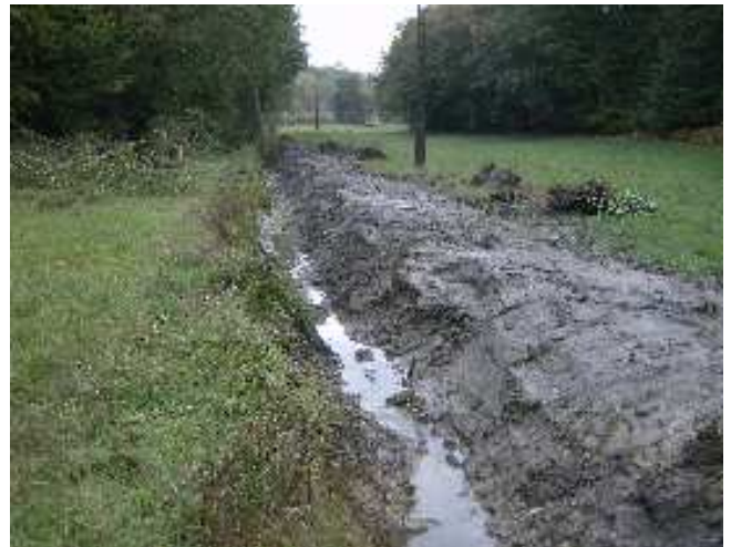
recalibrage du cours d'eau
