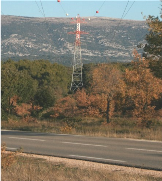
Superposition entre linéaires : route et ligne électriques
